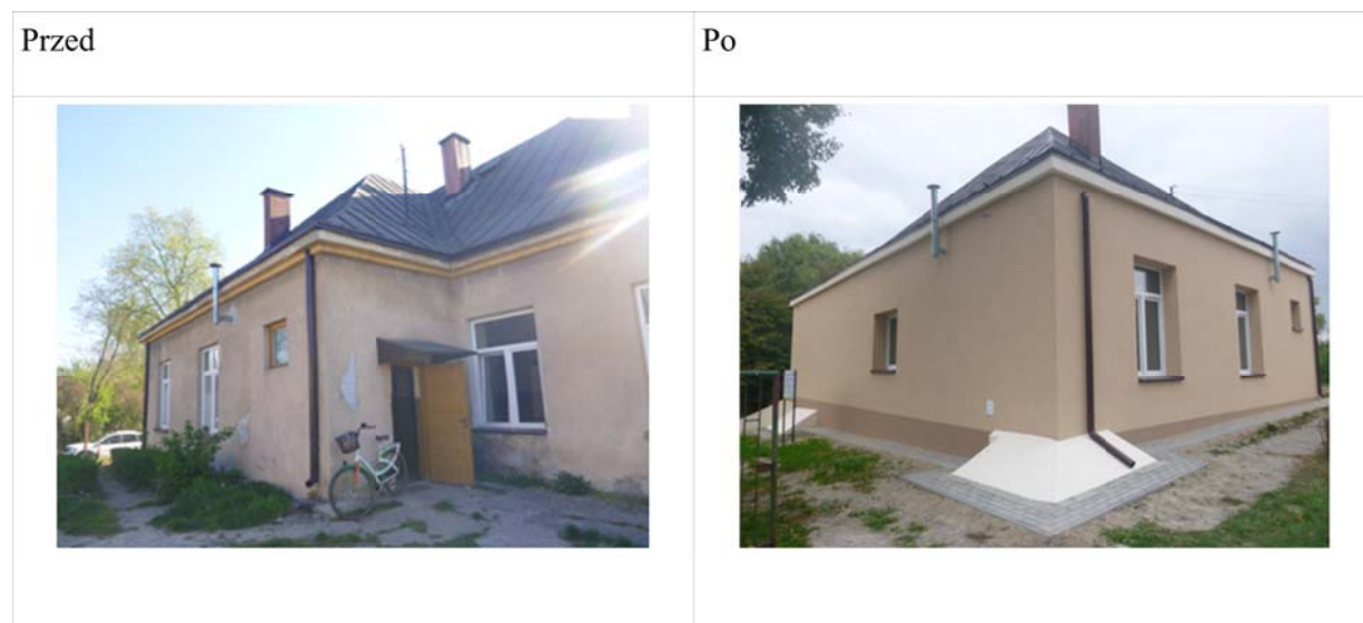
Zdjęcie 2. Budynek z mieszkaniami w miejscowości Bilczów
