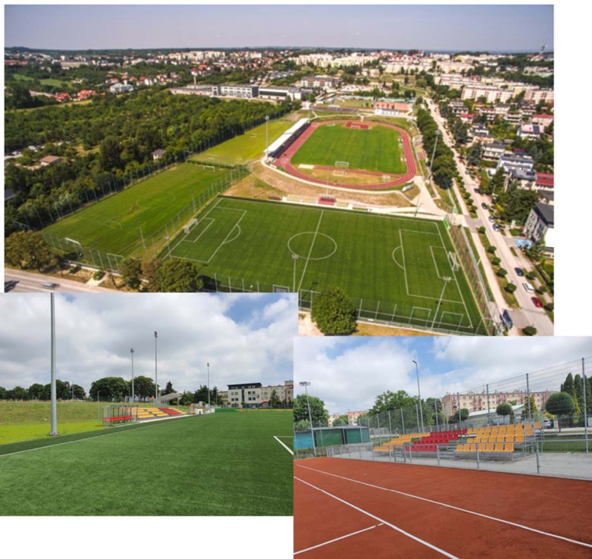
Zdjęcie 17. Stadion sportowy przy ul. Kusocińskiego po przebudowie
