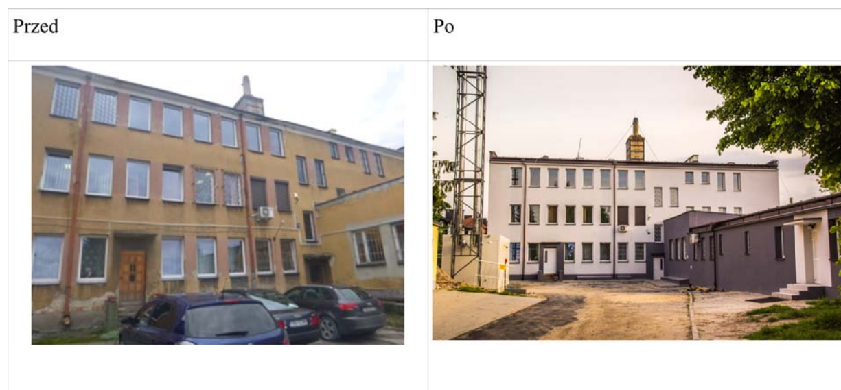
Zdjęcie 5. Budynek gminny położony w Busku-Zdroju przy ul. Różanej
