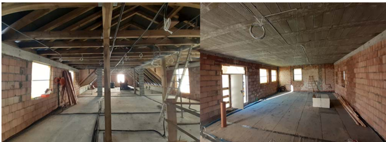
Zdjęcie 24. Adaptacja budynków przy ul. Bocznej
