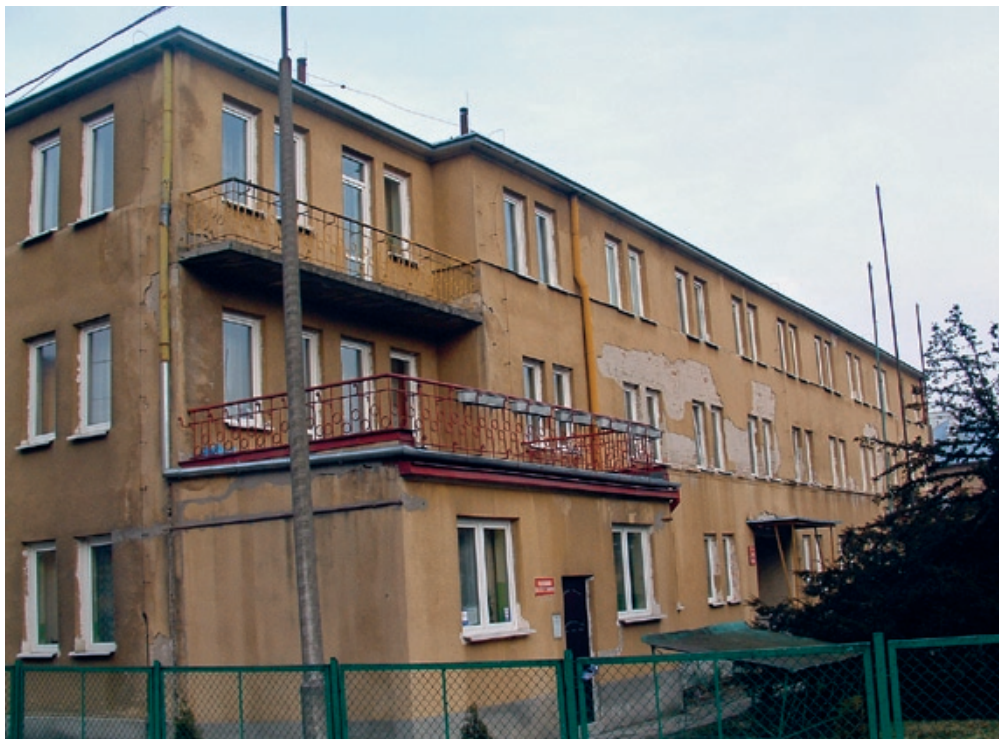
Ośrodek zdrowia przy ul. Sądowej w Busku-Zdroju przed remontem
