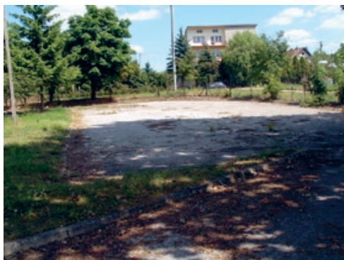
Stan parkingu przy ul. Grotta przed remontem
