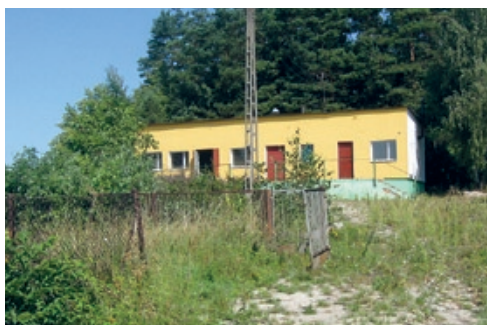
Budynek świetlicy w Broninie przed realizacją projektu
