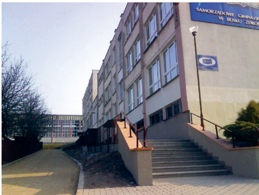
Wyremontowane ciągi komunikacyjne (chodnik i wjazd) oraz parking od strony sali gimnastycznej (SG Nr 1 i SP Nr 3 w Busku-Zdroju)
