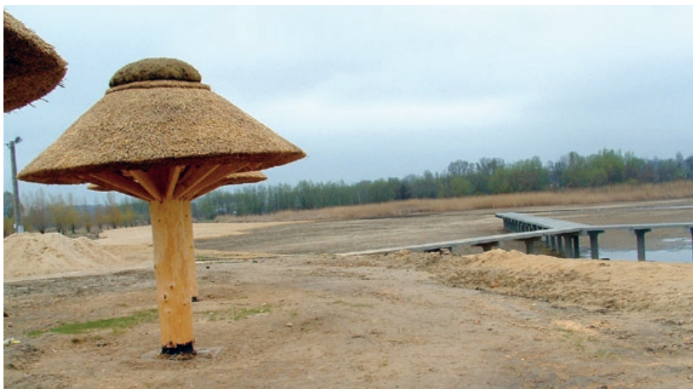
Prace przy zagospodarowaniu terenów rekreacyjnych w Radzanowie
