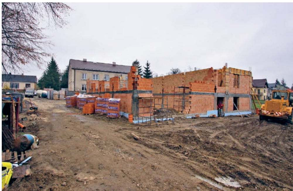
Sala gimnastyczna w trakcie budowy przy Szkole Podstawowej w Dobrowodzie
