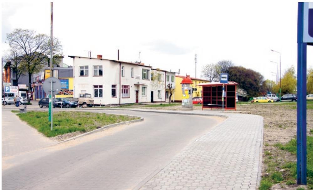
Zatoka autobusowa przy ul. Bohaterów Warszawy
