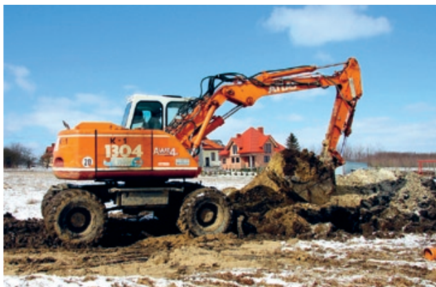
Prace przy budowie kanalizacji w Łągiewnikach
