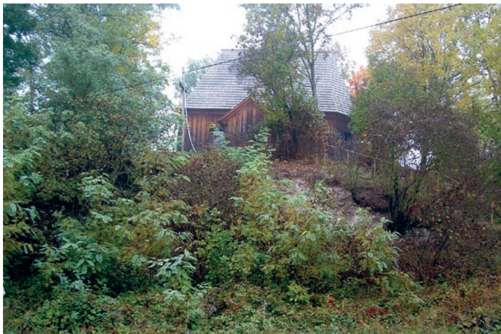
Teren przy Kościele św. Stanisława Bpa przed dokonaniem prac remontowych
