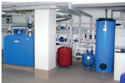
Zmodernizowany system grzewczy, układ zasilania pompowego i instalacji elektrycznej (SP Nr 2 w Busku-Zdroju, SG w Podgajach)
