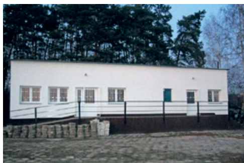
Budynek świetlicy w Broninie po modernizacji
