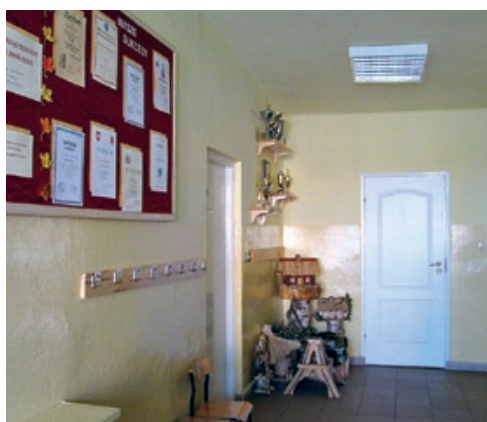
Wymienione drzwi w salach lekcyjnych (SP Kostki Duże)
