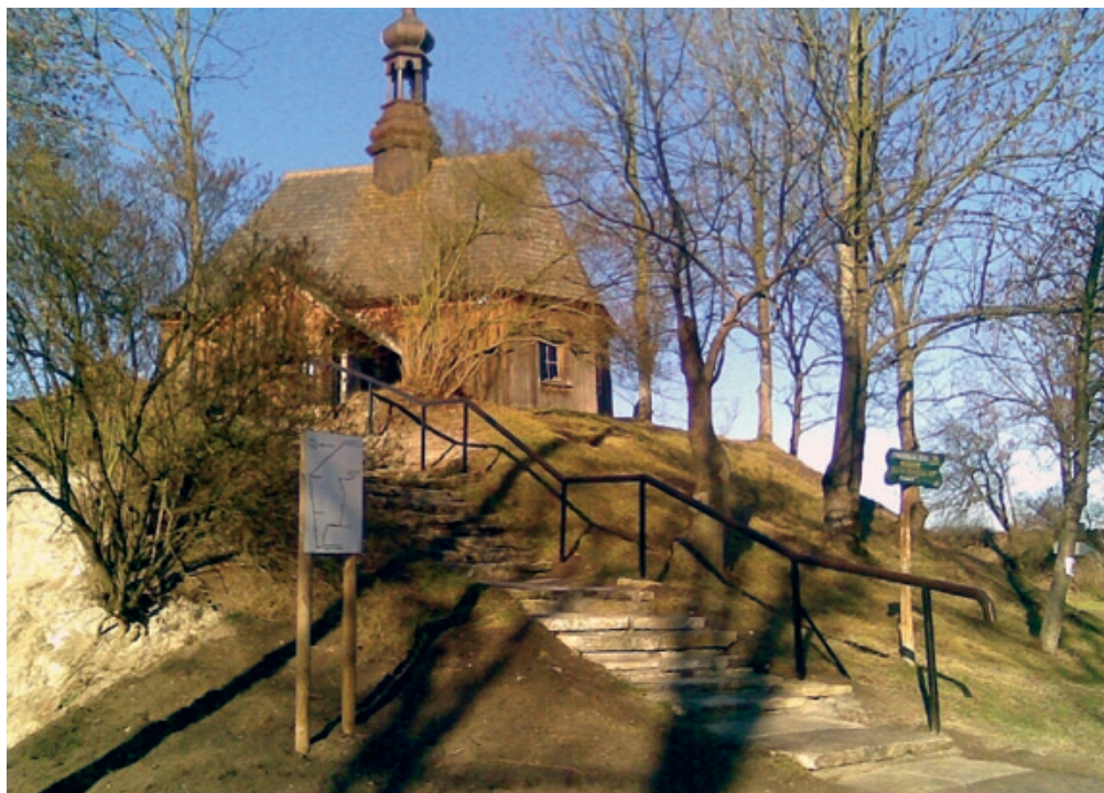
Teren przy Kościele św. Stanisława Bpa po dokonaniu prac remontowych
