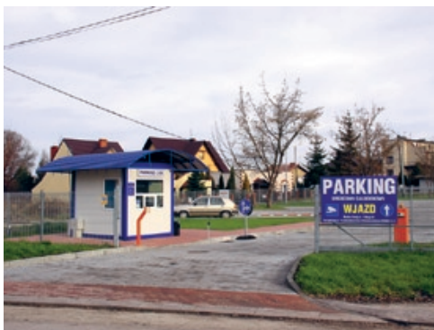
Parking przy ul. Grotta po przebudowie
