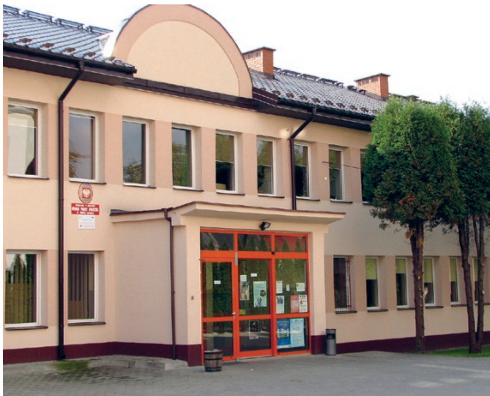
Budynek MGOPS po remoncie
