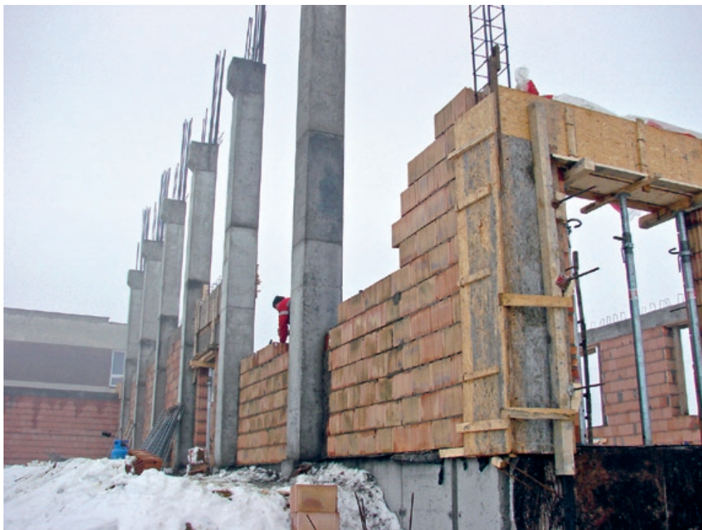
Sala gimnastyczna przy Szkole Podstawowej w Kołczkowicach – plac budowy
