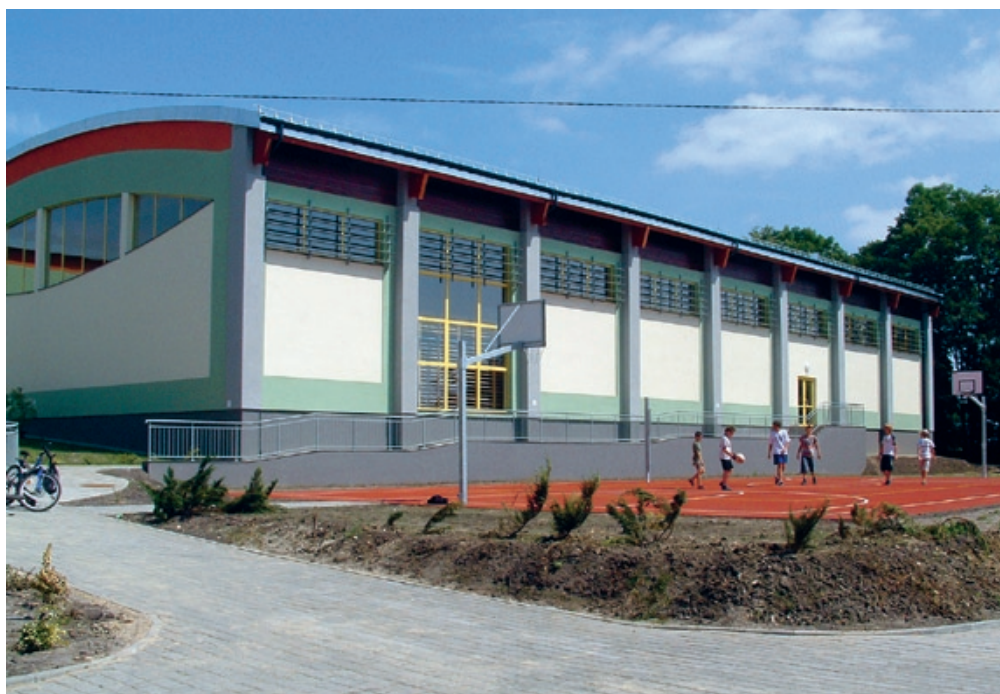
Obiekty sportowe przy SG w Zbludowicach – hala sportowa oraz boisko do koszykówki (hala została wyposażona w instalacje i sprzęt sportowy, rozbudowano kotłownię gazową, wykonano przyłącza kanalizacji deszczowej, na terenie wokół hali zrobiono ciąg pieszy i elementy małej architektury)
