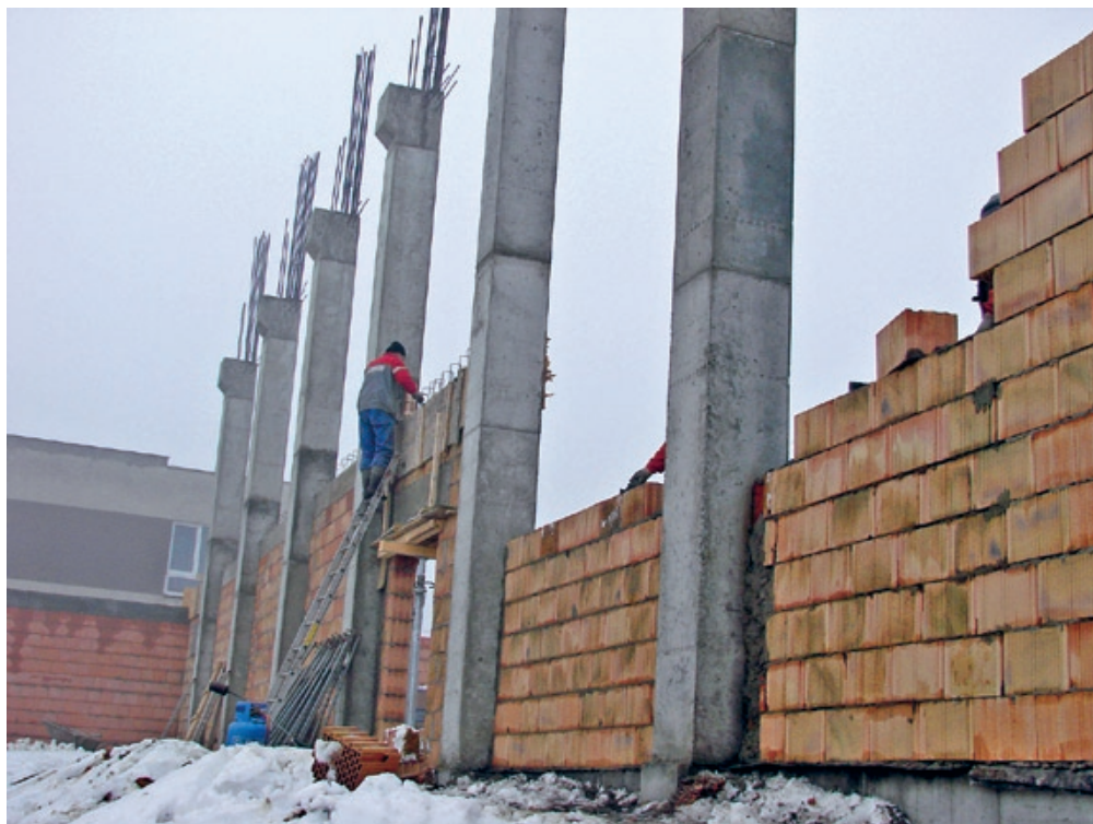
Realizacja zadania pn. „Rozbudowa bazy edukacyjnej w Gminie Busko-Zdrój” w ramach którego wybudowane zostaną sale gimnastyczne przy SP w Kołaczkowicach i Dobrowdziej
