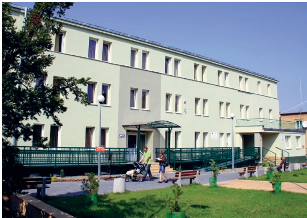
Ośrodek zdrowia po modernizacji
